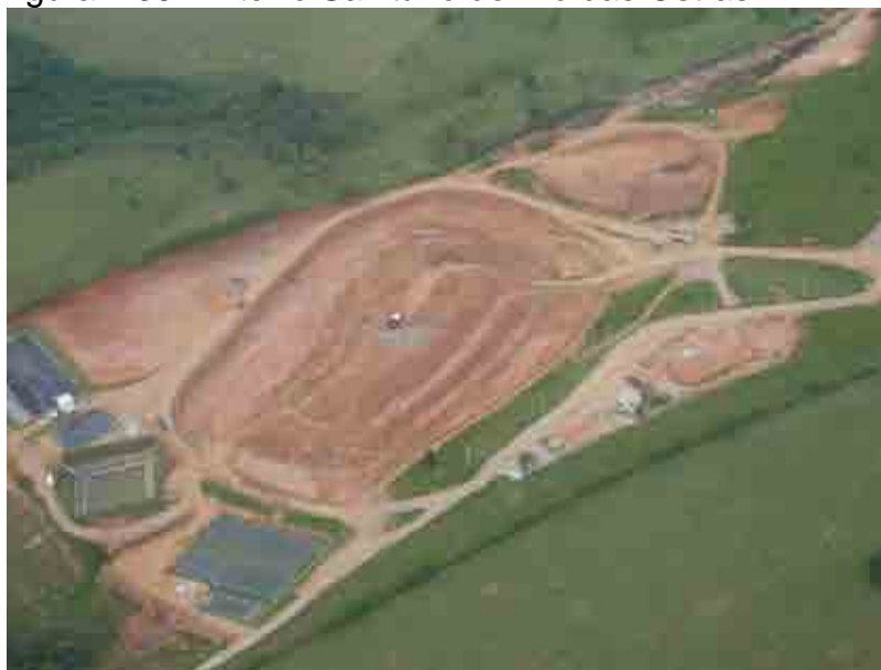
Figura 2.39 – Aterro Sanitário de Rio das Ostras
