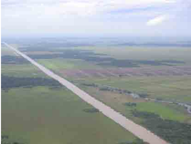
Figura 1.24 – Canal retificado do rio São João, herança das obras do DNOS
