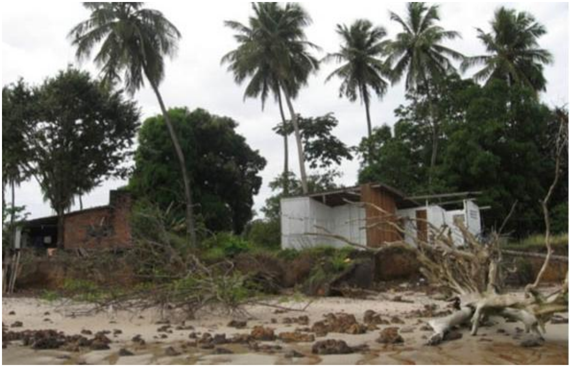
Figura 2.11 Habitações em processo de destruição pela erosão. Fonte: SEMA (2007)
