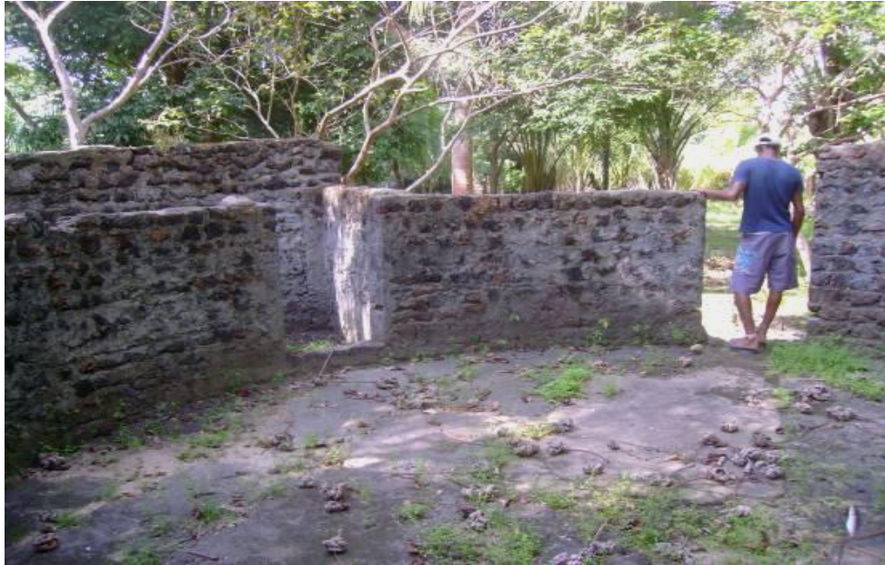
Figura 2.69 Vista da construção circular existente na Vila de Fortalezinha. Fonte: SEMA (2007)
