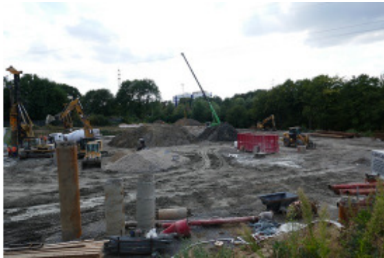
Abb. 49: Bau Regenüberlaufbecken am Nordpark
