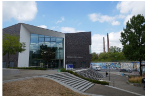
Abb. 22: Hörsaalgebäude Universität Duisburg-Essen
