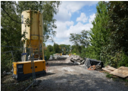
Abb. 14: Brücke Pferdebahnstraße im Bau
